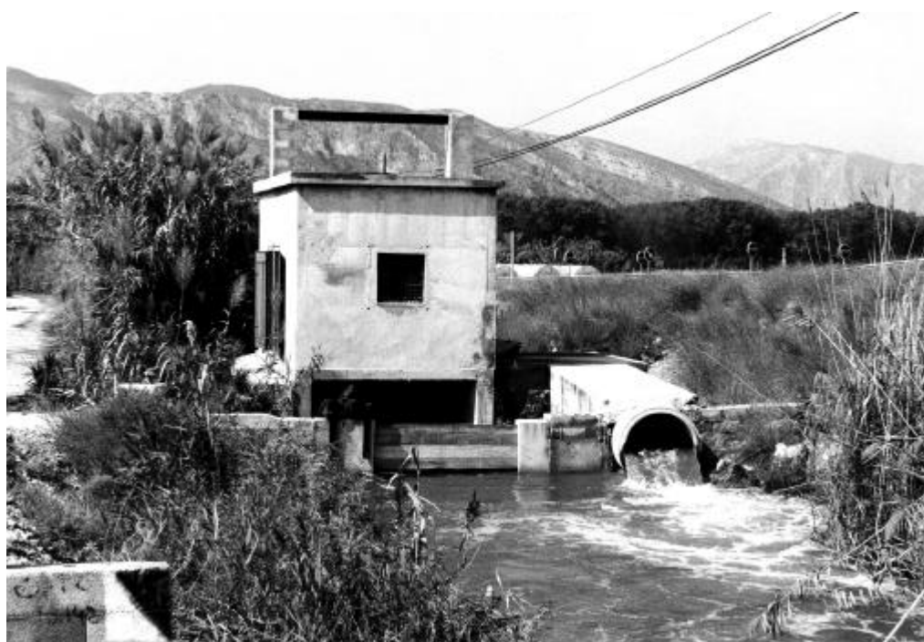
Infraestructuras de regadío en zonas húmedas de interés ecológico. Marjal de La Safor, Comunidad Valenciana, España. Foto: SEHUMED
