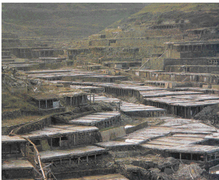
Foto 8. Salinas de Añana (Álava, España). Se trata de una explotación salinera singular de origen romano, caracterizadas por su diseño en terrazas de madera, escalonando la ladera. Actualmente se encuentran en fase de restauración.
