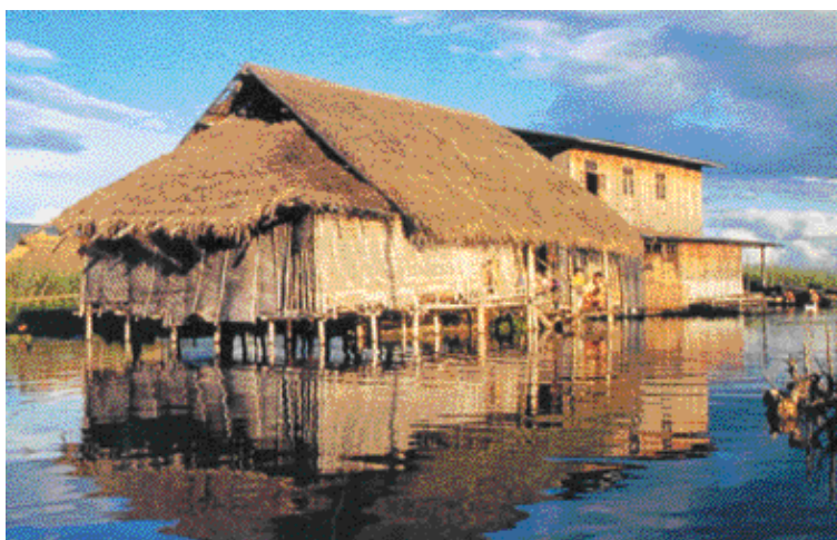
Foto 20. Chozas palafíticas pertenecientes a la Aldea Tyssa en el lago Inle (Myanmar). Estas construcción se realizan sobre pilotes directamente sobre las aguas o sobre el área palustre.
