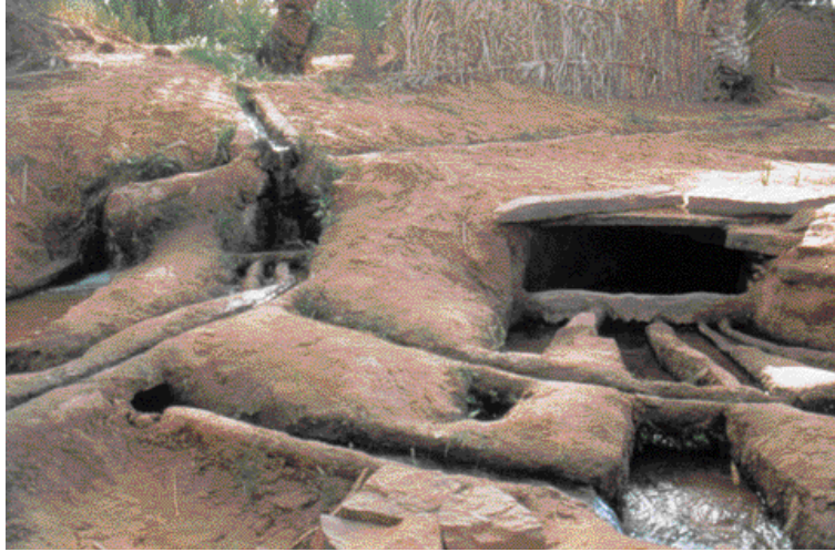
Foto 25. Fouggara sobre un wadi en Adrar (Argelia). Se trata un ingenioso sistema hidráulico para la captura y distribución de las aguas subterráneas. Fouggara on a wadi in Adrar (Algeria). This is an ingenious hydraulic system for collecting and distributing underground water.
